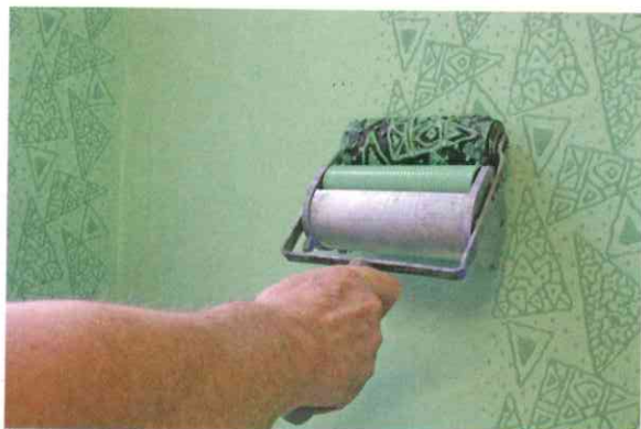
Auftrag von Leimfarbe mit der Farbrolle Foto: Birger Jesch
