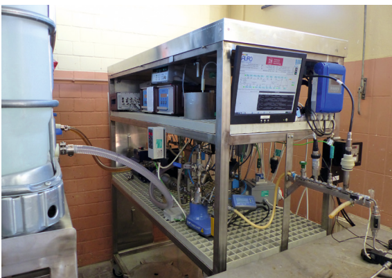
Abb. 6 // Automatisierte Anlage zur verlustfreien Herstellung der Bindemittlemulsion.
